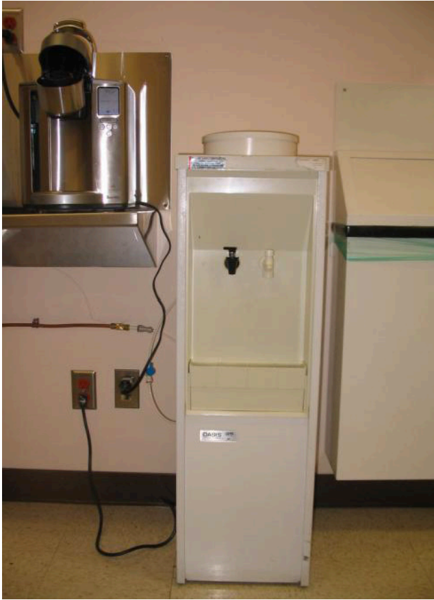
Figure 1: Raccordement d'un refroidisseur à l'aqueduc (option 3)
